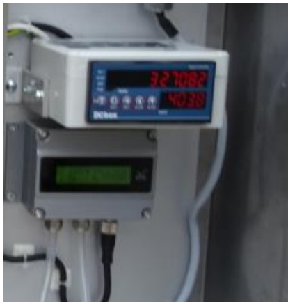
Rysunek 2. Panel pomiarowy (rejestrator i sumator) przepływomierza stosowanego w nowych stacjach ASS-500
