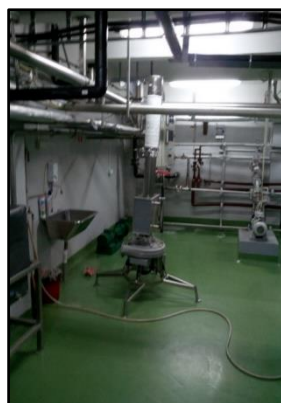
Rys. 5. Pobór aerozoli atmosferycznych w przepompowni obiektu nr 35
