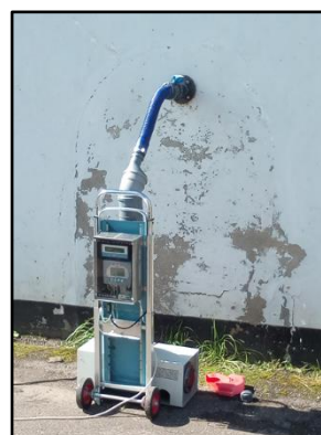
Rys. 6. Stacja do poboru aerozoli powietrza z kranów w obiektach 2 i 3 w KSOP w Różanie (prod. CLOR)
